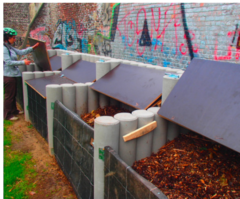
| Une station de compostage ouverte aux habitants gérée par la Commune de Schaerbeek.
